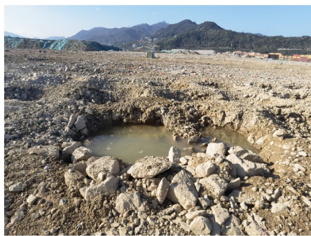
b) 夯坑渗水积水
