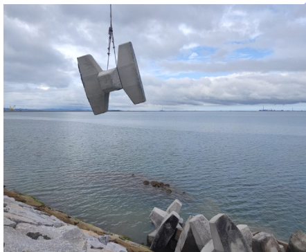
c) 水下吊装试验
