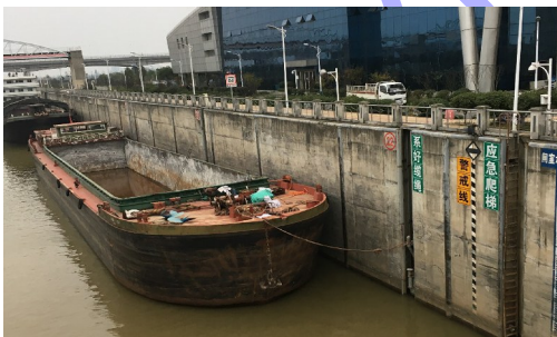
图2 湘江某船闸浮式系船柱系缆实景
