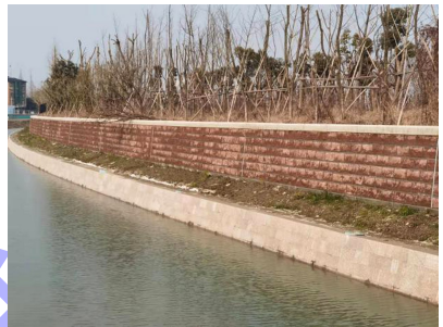
图8 劈离砌块护面挡土墙效果
