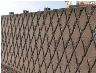
图7 免凿毛模板的浇筑效果
