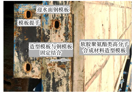
图 4 现场造型模板与钢模板结合
