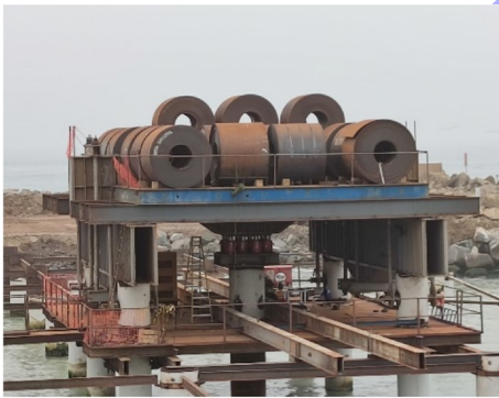
图2 试桩静载试验反力系统
