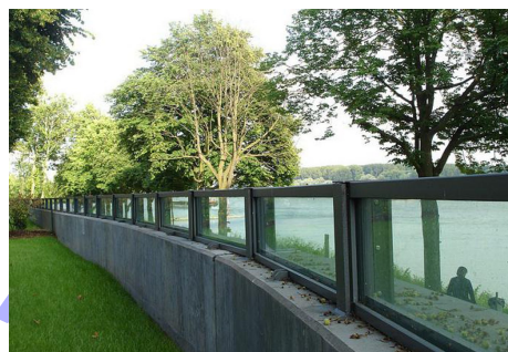
图 5 通透式玻璃防洪墙实景图
