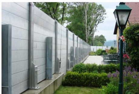
图 4 装配式闸板组合防汛墙实景图
