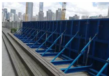
图 6 活动式闸门防汛墙实景图
