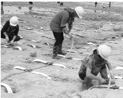
图 3 蝶形接头与钢丝软管支管连接
