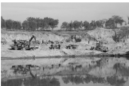
图4 大方量开挖河岸
