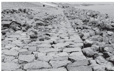
图7 枯水平台及挡墙出现沉陷滑移
