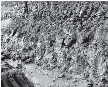
图4 开挖后淤泥质及渗流严重的土质
