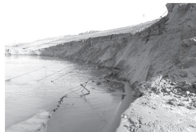
崩窝连续发生使岸线呈锯齿形, 形成较多矾头, 不利于护岸的稳定。为保证岸线的平顺, 防止岸线继续崩塌, 采取抛枕及抛石措施补填窝崩的区域, 将原有枯水平台的位置向岸侧适当移动, 以有利于枯水平台的施工, 尽可能地减少岸坡的回填, 适当增大水下镇脚的范围和强度, 确保护岸的稳定。在本项目中, 对已完成沉排护底但发生窝崩现象的区域采取先进行抛枕补坡, 补到缓于1:2.5的设计坡比后再进行抛石镇脚, 待岸坡整体稳定后进行枯水平台及护坡工程的施工。对还未实施沉排护底区域则增设抛枕补坡和镇脚工序, 具体要根据实际地形分别进行抛枕补坡和抛枕镇脚。待岸坡稳定后再进行沉排护底的施工, 随后在排体之上抛石镇脚。经过以上处理,
