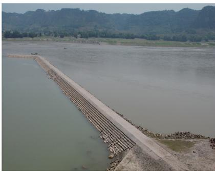
图3 铰链排护坡结构
