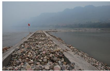
图4 混凝土箱体坝结构
