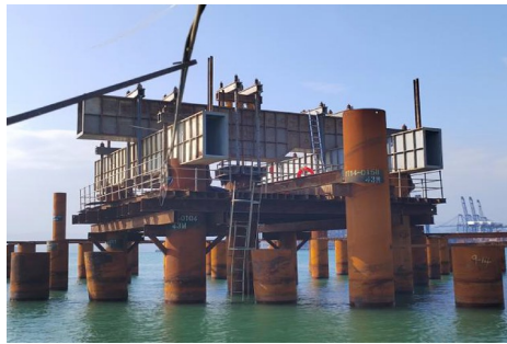
图 2 试验现场 Fig. 2 Test site
