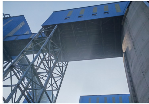
a) 廊道外露构件
