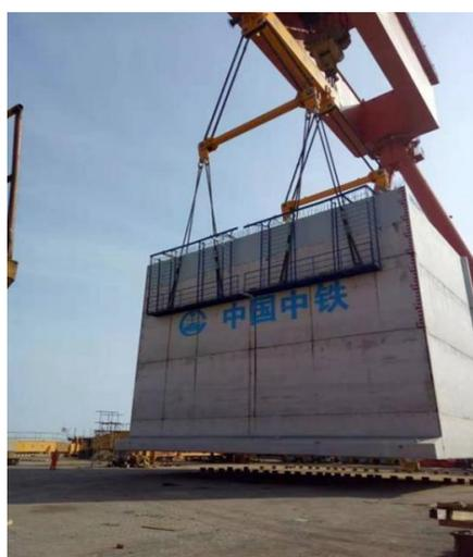
图4 吊具与沉箱吊点的连接
