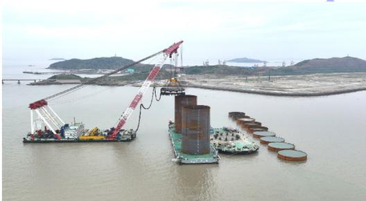
图7 起重船移船取筒
