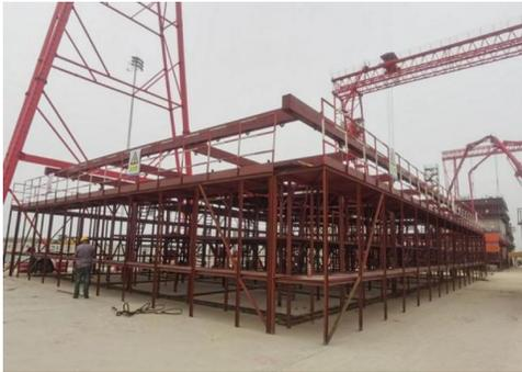
图2 整体钢筋绑扎架
