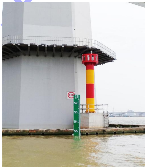
图3 桥墩警示标安装效果
