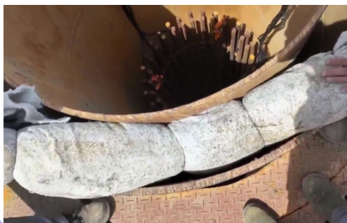
图5 内外护筒之间铺设沙袋止浆
