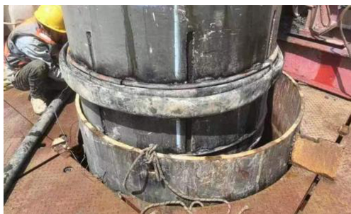
图4 内护筒外侧附带止浆环
