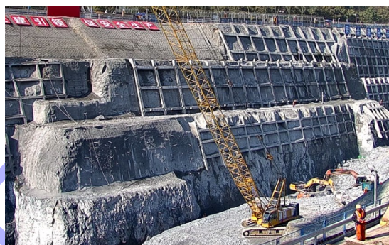
图 12 右边坡 B-2 支护完成状态 Fig. 12 Ssupport completion status of right slope B-2
