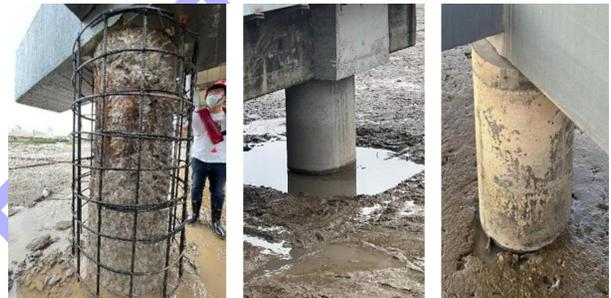
a) 玄武岩纤维筋笼安装 b) 完工效果 c) 2年后效果
