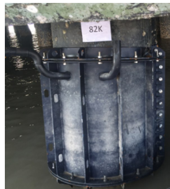
图 7 典型桩基修复效果
