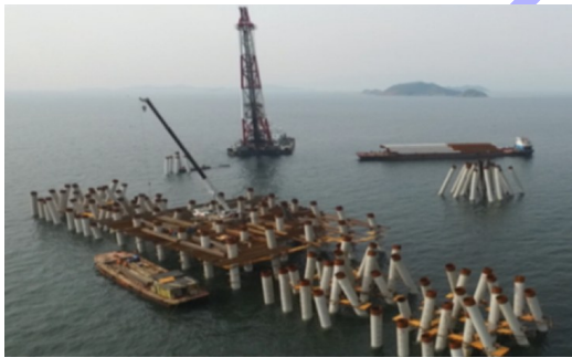
图 1 码头现场桩基
