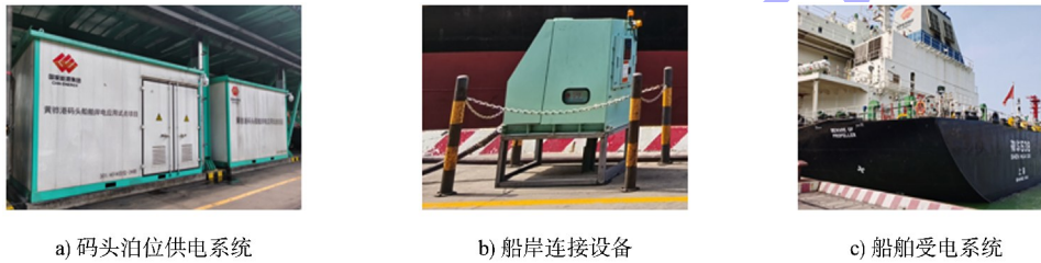
图1 船舶岸电系统基本构成
