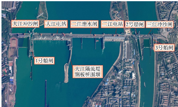
图 1 葛洲坝水利枢纽全貌
