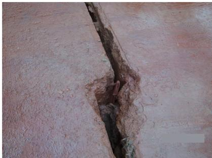
图2 发生损坏的凹凸缝
